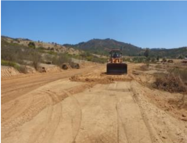
Terraplenes para plataforma de canal, km 30.700.
