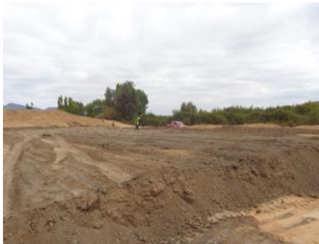
Terraplén para tranque la Vega Alta, km 27.400.
