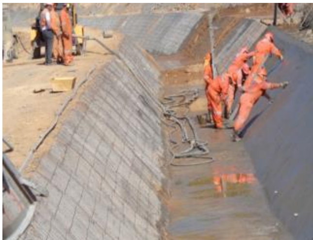
Hormigonado de talud, km.14.500.
