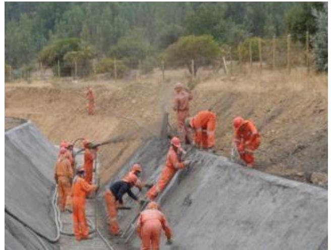
Hormigonado de canal, Km 14.400.
