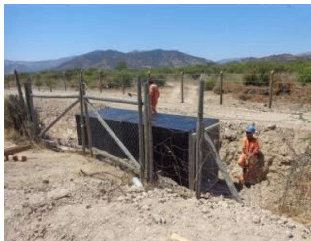
Construcción de paso predial, Km 13.290.
