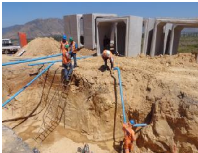
Excavación para colocar cajones en obra de arte N°4, Km 21.760.
