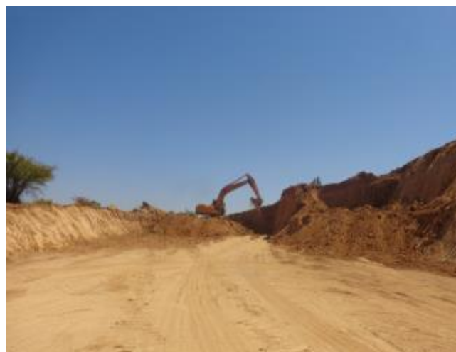
Corte en terreno, km 31.200.
