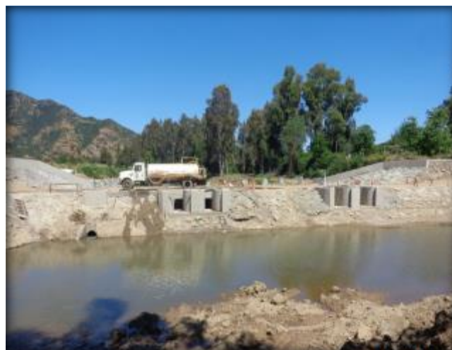
Vista panorámica, Bocatoma Canal Lolol Sur.
