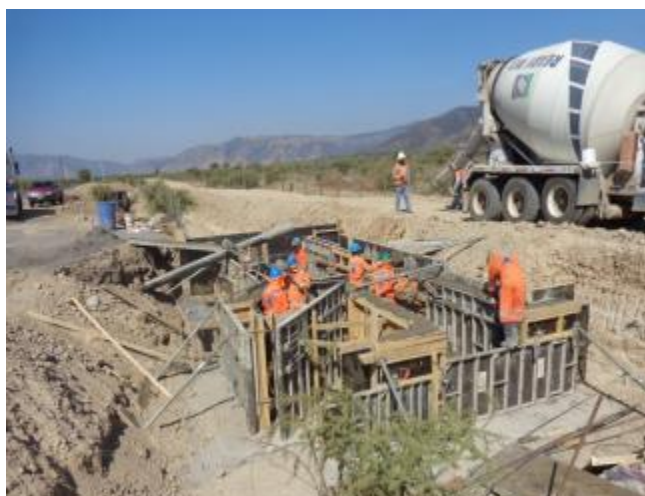
Hormigonado de muro del marco partidor, obra de arte N°7.
