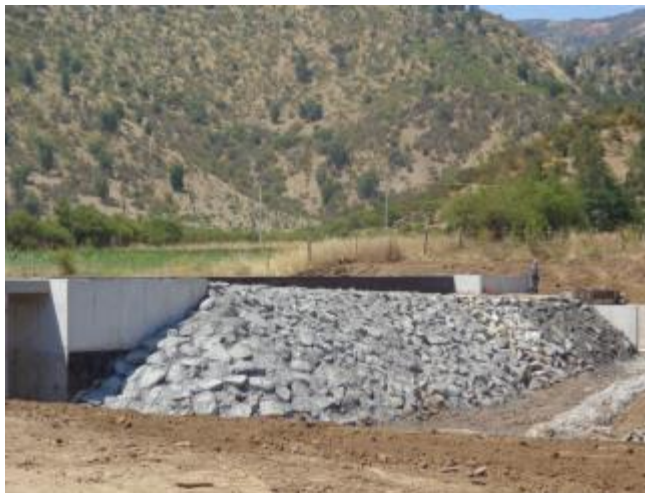
Bocatoma, enrocado de protección.
