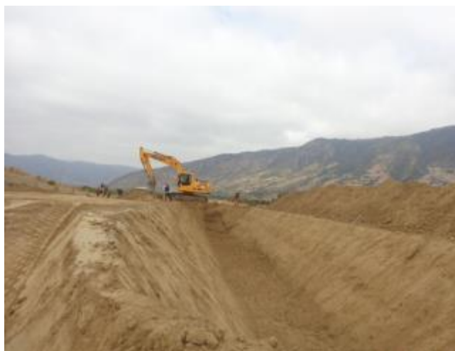
Construcción de terraplenes y corte canal, Km 8.640.
