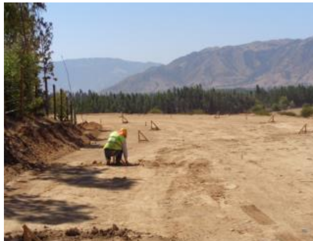
Replanteo de taluceras para corte de canal, Km 28.800.
