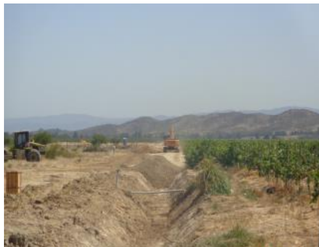
Movimiento de tierras en canal secundario Tres Esquinas, km 0.500
