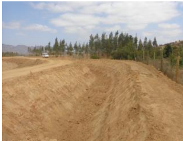
Corte de canal, km 30.000.
