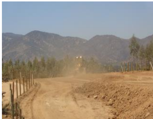
Construcción de terraplén para plataforma, km 30.000.
