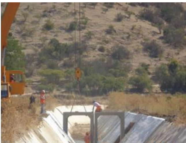
Montaje de cajones en paso predial, Km 6.670.
