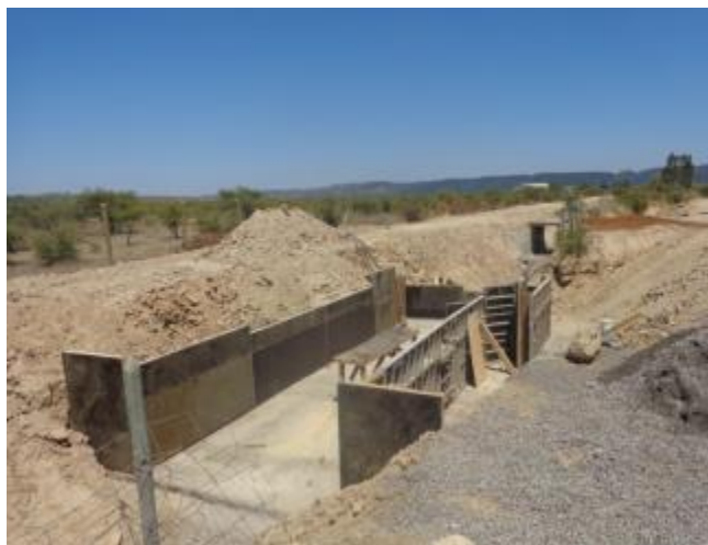
Preparación de moldaje, marco partidor, obra de arte N°7.
