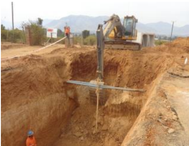
Excavación obra de arte N°3, Km 21.360.
