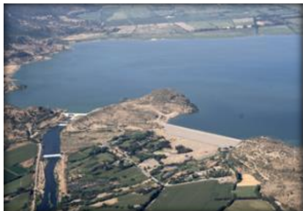
Zona de Presa y Embalse Convento Viejo.
