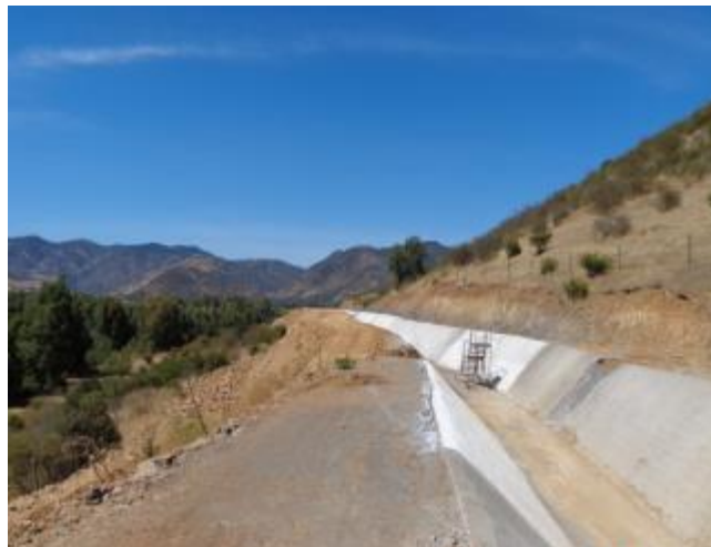
Reparación del canal, Km 11.600.
