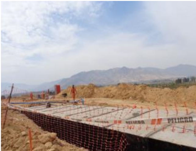
Cajones colocados en obra de arte N°4, Km 21.760.
