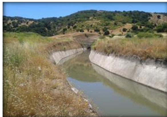
Sector de salida poniente Túnel La Lajuela.
