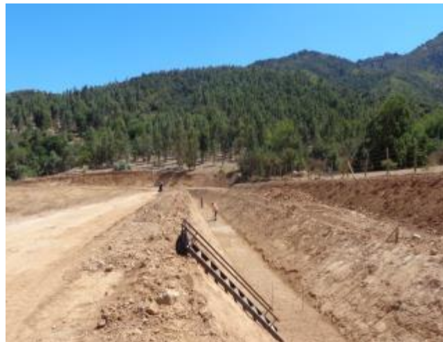
Preparación de fondo de canal para hormigonado de revestimiento, Km 14.600.
