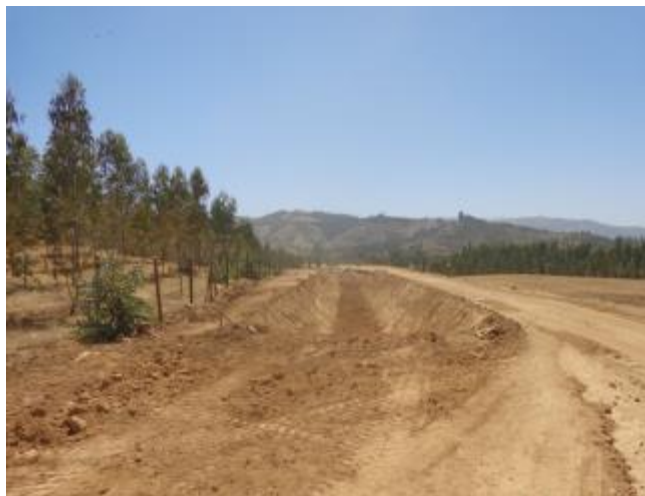
Corte de canal, Km 29.000.
