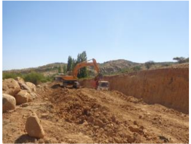
Corte en terreno, km 30.100.
